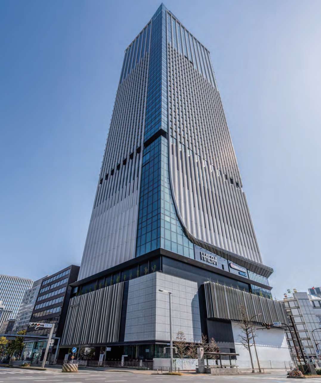
ザ・ランドマーク名古屋栄外観（北西側）
