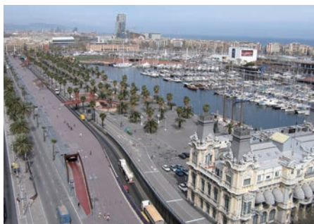
道路を地下化することでウォーターフロントと旧市街とを結ぶことに成功した
