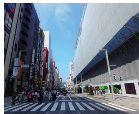
銀座六丁目交差点(右側が松坂屋銀座店跡地で行われて いる「銀座六丁目10地区第一種市街地再開発事業」)
