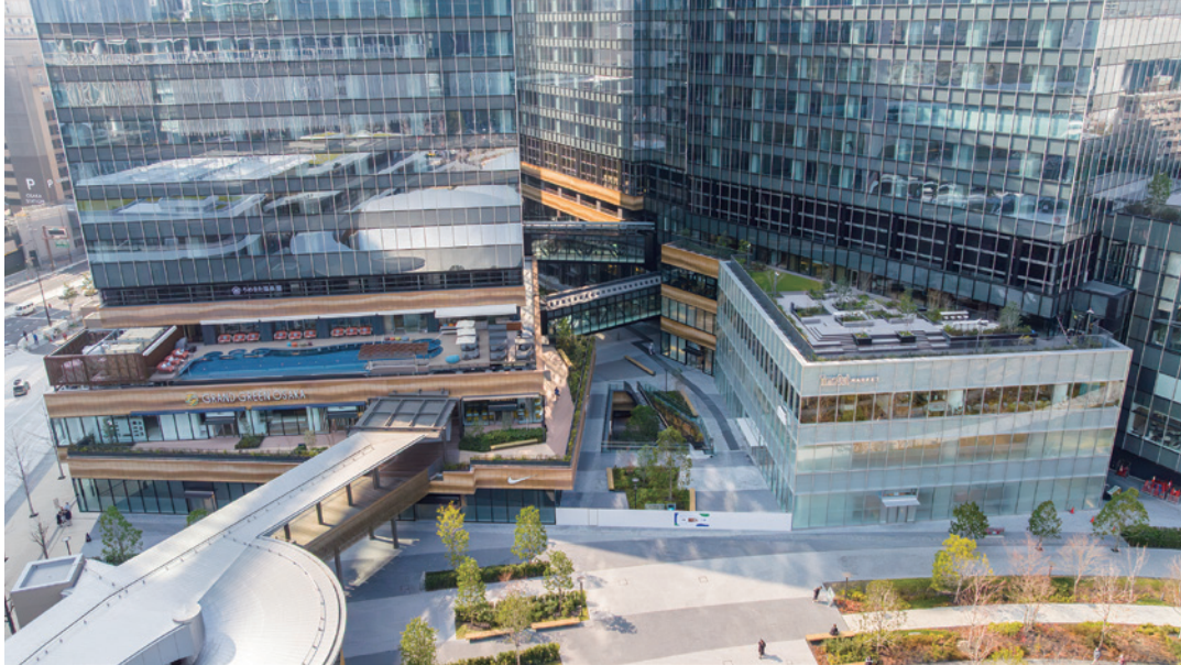
商業施設「ショップ&レストラン」が入る南館低層部(提供:グラングリーン大阪開発事業者)
