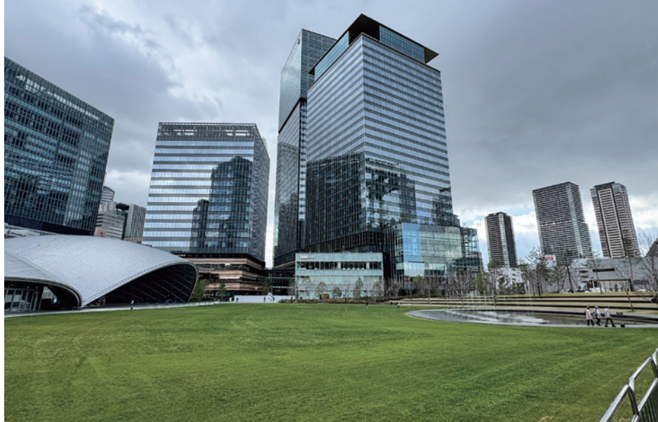
広大な芝生のある「うめきた公園」から見る南館
