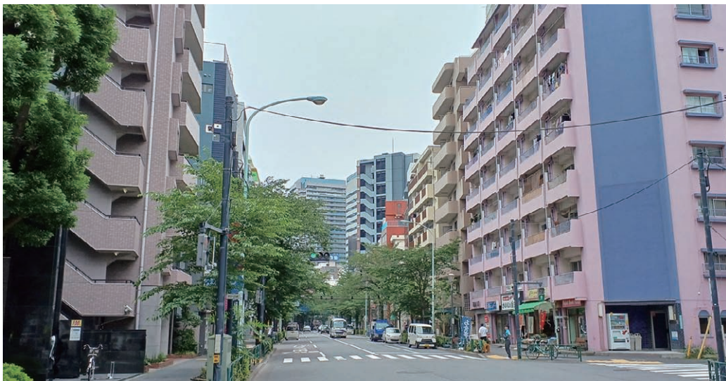
都内の緊急輸送道路沿いは利便性が高く、昭和後期からマンションが多く立地してきた
