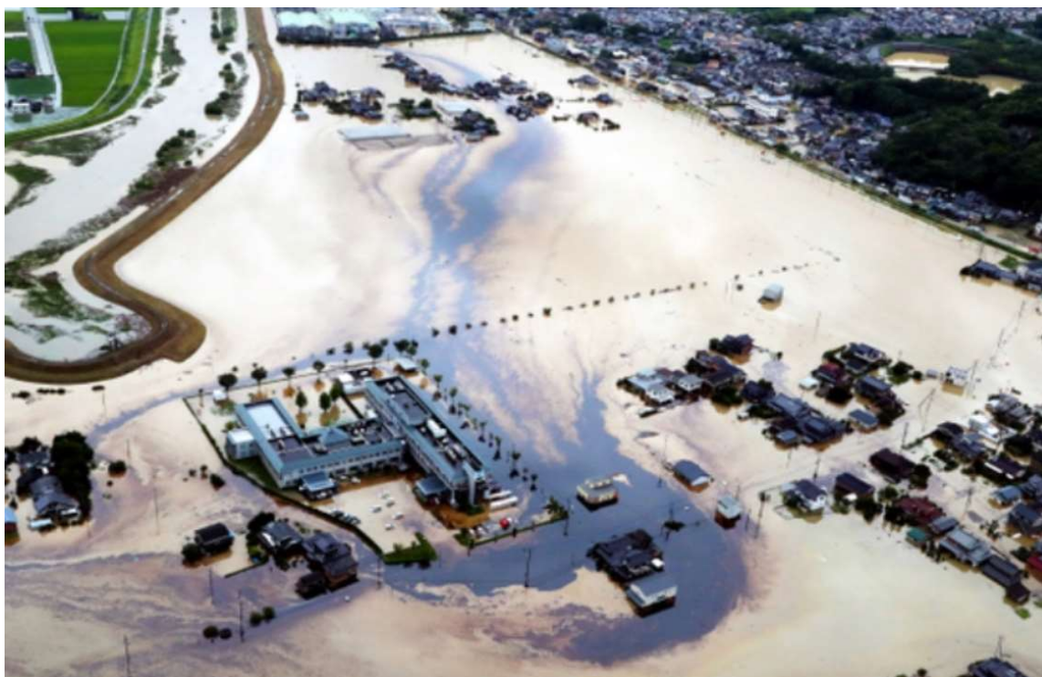
写真10 2019年8月の前線に伴う大雨によるS鉄工所からの油流出事故
