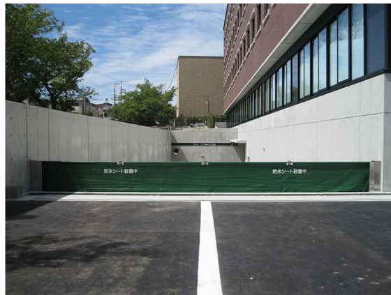
写真6 事例 C:分譲マンションの防潮板整備例
