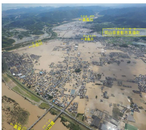
写真2 平成30年7月豪雨による岡山県真備町の被災状況
