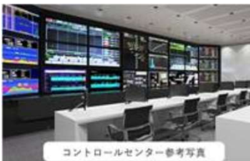
写真9 コントロールセンター(中央監視室)
